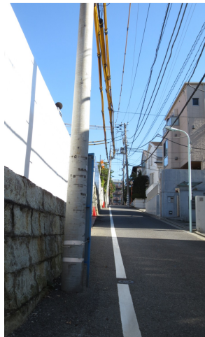
急坂の工事現場
