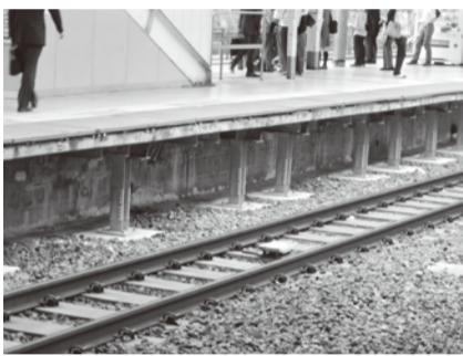
ホームドア設置のため補強された田町駅ホーム
