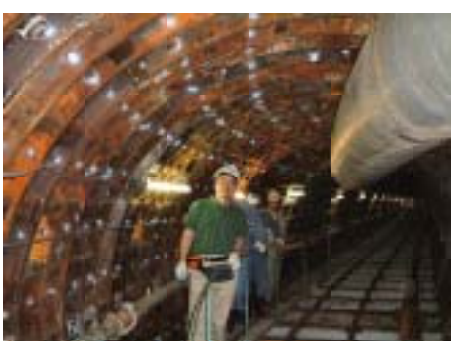
目黒通り下に設置された雨水貯留管内部
