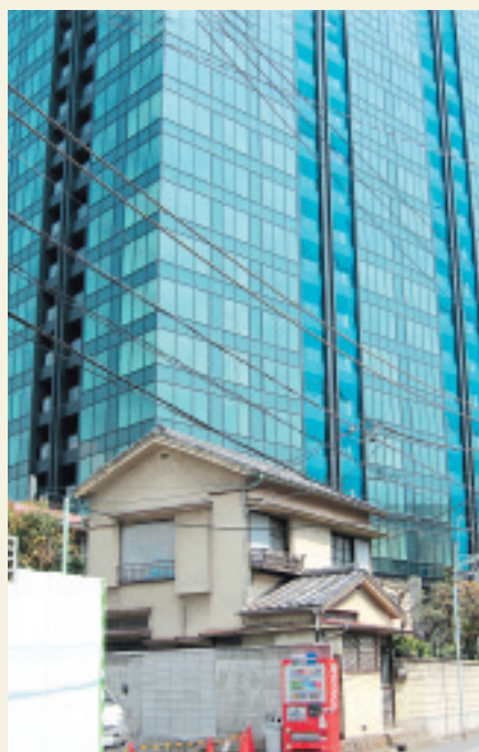
戸建て民家に隣接する巨大ビル（三田小山町）
