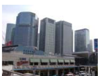
海風を遮る巨大な屏風岩(品川駅東口)
