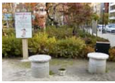
下水道直結型仮設トイレ(災害時には、座板をはずし仮囲いをする)
