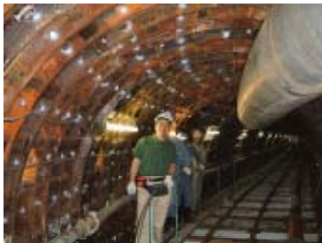
建設中の貯留管を視察する、くぼた光前都議(=03年6月30日)
