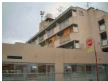
1階は保育園、上層部が都営住宅
