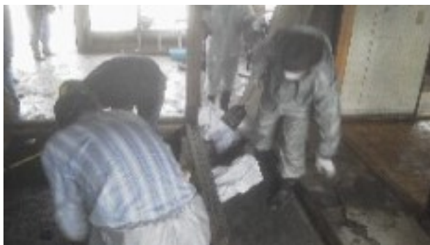
5月29日 泥出し作業 湊地域
