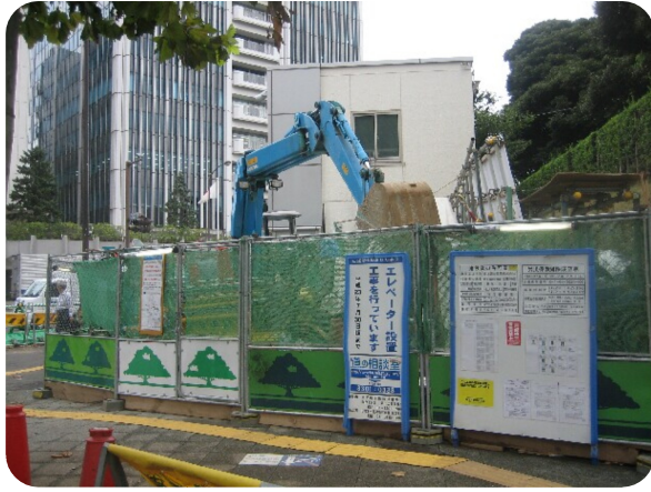
エレベーター工事中の青山一丁目駅
