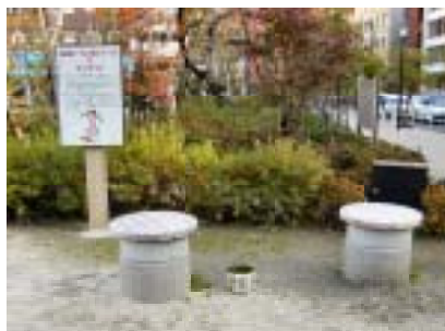
南桜公園の下水道直結型仮設トイレ (災害時、座板をはずし仮囲いをする)
