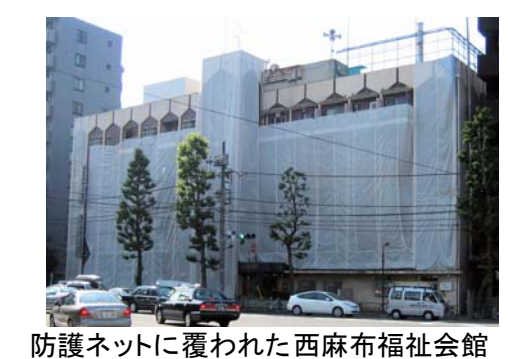
防護ネットに覆われた西麻布福祉会館
