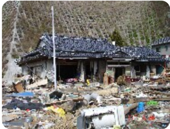
津波被害を受けた福島県塩谷海岸付近の住宅
