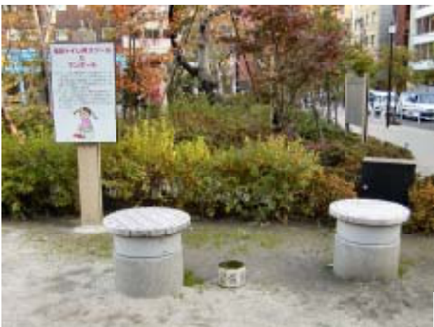
南桜公園(西新橋2)の下水道直結型仮設トイレ (震災時はベンチの板をはずし、囲いをする)
