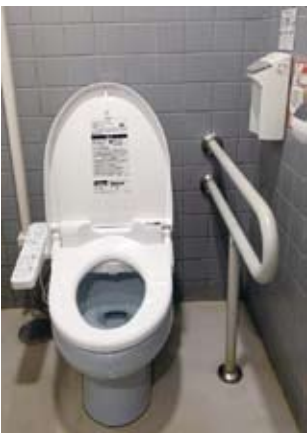
すぐに改修されたトイレ
