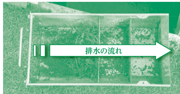
区立学校の排水口に設置されたるろ過装置
