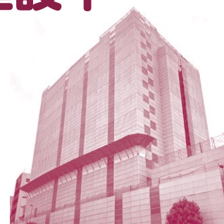
建設中のデータセンター
