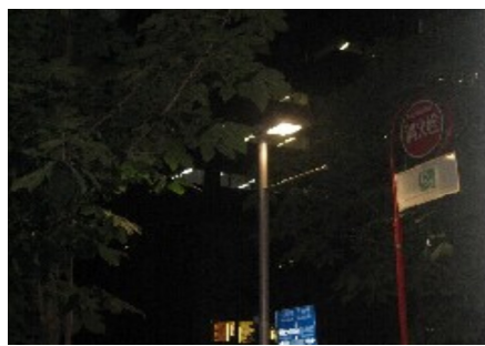
点灯された歩道の街路灯
